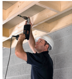
Afb. 5.20: Hep 2 O is gemakkelijk aan te leggen bij houten balken. De leidingen kunnen gewoon door de geboorde gaten worden getrokken.
